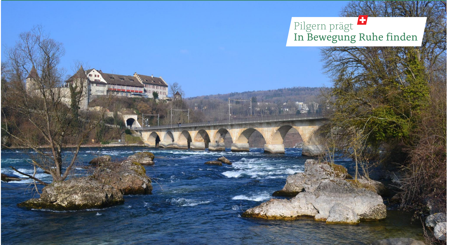
Eisenbahnbrücke Schloss Laufen am Rheinfall
